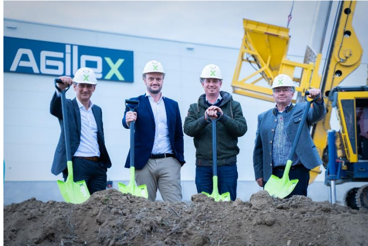
Gemeinsamer Spatenstich für das AGILOX Headquarter.
