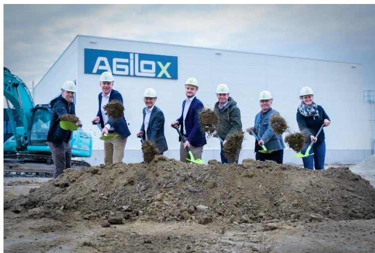
Gemeinsamer Spatenstich für das AGILOX Headquarter.
